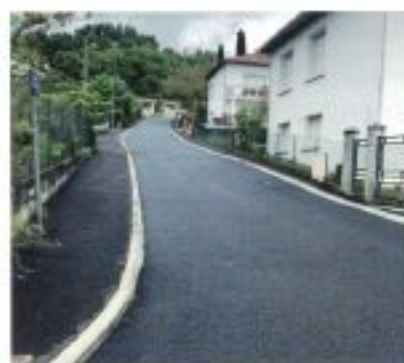
Réfection de la chaussée enrobée, Chemin du cimetière (bourg).
