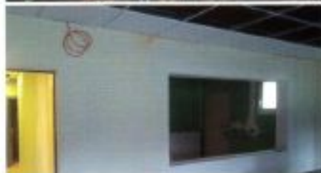
Réfection de la salle Jean-Gérard Debats (agrandissement des vestiaires des filles et des locaux pour le personnel d'entretien)
